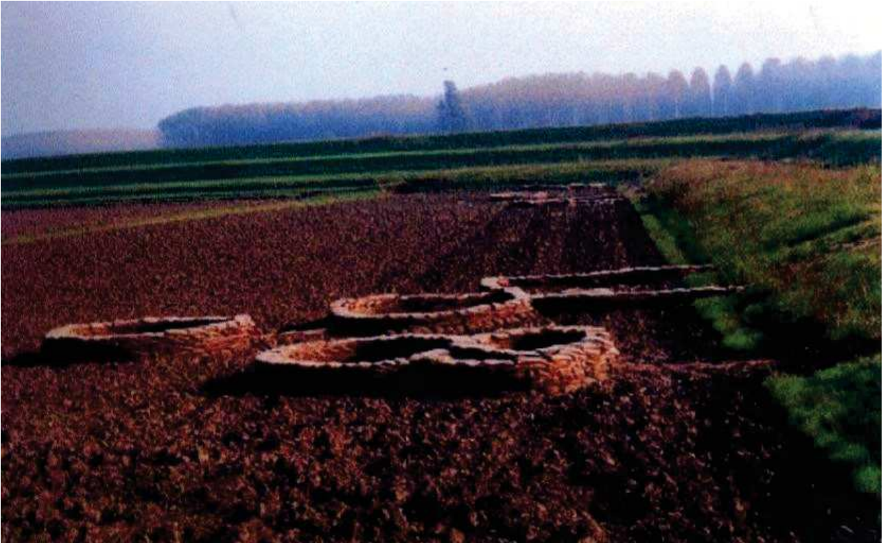
Esempi di fontanazzi nelle vicinanze dell'argine maestro
