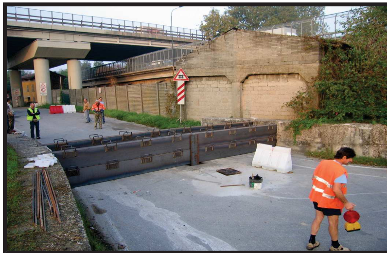
VARCO n.2 – vista da via del Pontiere
